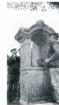
Abbildung 1.8: Konrad Föhning und Franz-Josef Götte bei Renovierungsarbeiten
