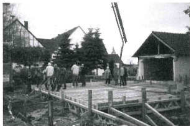
Abbildung 1.14: Das Fundament wird gegossen
