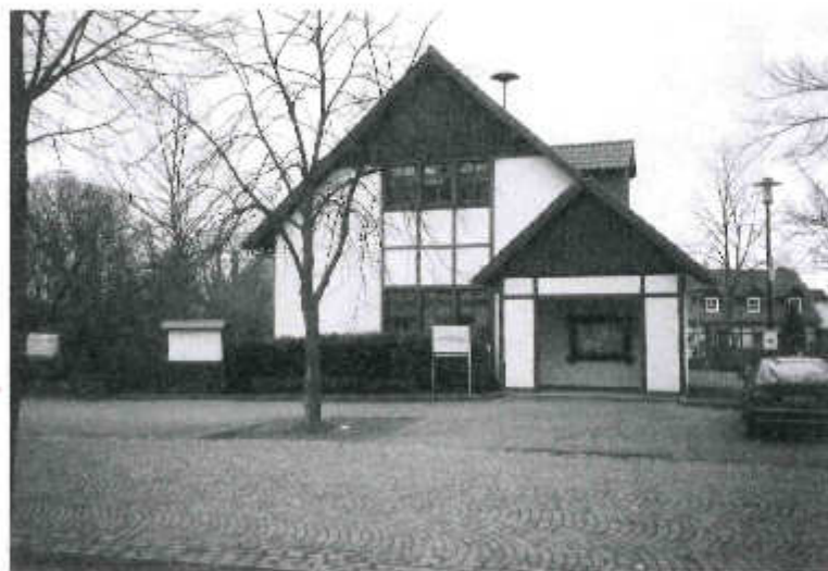
Abbildung 1.17: Das Feuerwehrhaus steht giebelseitig zur Dorfstraße hin. Es fügt sich harmonisch in das vorhandene Ortsbild ein und wird eine Bereicherung für die ganze Ortschaft Weiberg sein (zit. aus dem Stadtspiegel Nr. 46).
